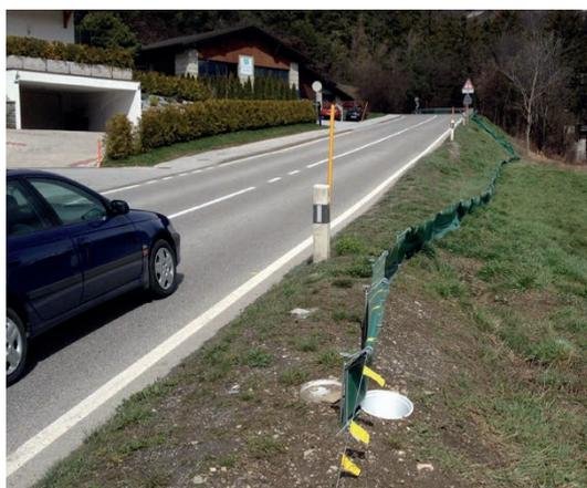
Barrières amovibles permettant de canaliser les batraciens vers des seaux, d'où ils sont ensuite récupérés et transportés jusqu'au lieu de ponte au-delà de la route.
