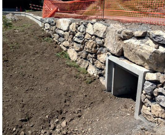
Un des nouveaux crapauducs installés à Morgins, avec les collecteurs en béton (en haut à gauche) permettant de canaliser la migration des batraciens vers le passage sous voie.
