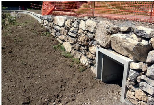
Eine der neuen Unterführungen in Morgins. Die Betonelemente entlang der Strasse (oben links) sollen die Amphibien Richtung Tunnel führen.
