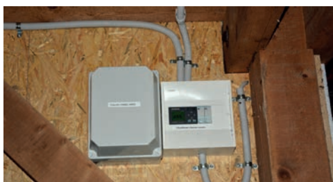
Photo 2 à 4: Chambre isolée (sagex blanc) aménagée dans les combles, avec porte (accès pour les humains) et fenêtre de passage pour les chauves-souris; vue intérieure de la chambre avec points d'accrochage installés sous le plafond et dispositif électronique de contrôle du chauffage avec horloge de programmation.
