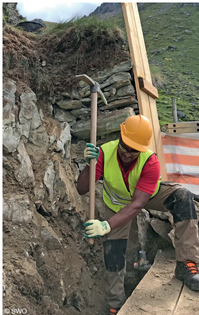
Rénovation d'un mur en pierres sèches à Nendaz.
