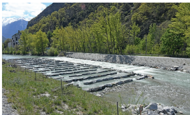
Fig. 4: La rampe à poissons de Chatzuhüs vue d'aval. (Photo: P.-A. Oggier)
