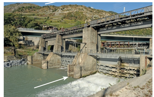
Fig. 1: L'échelle à poissons du barrage de Susten. A gauche coupe du pilier, à droite en haut les escaliers, en bas la flèche montre l'entrée de la rampe. (Photos: P.-A. Oggier).
