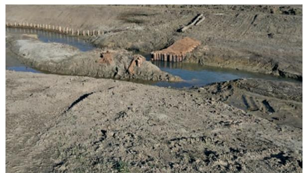
**Fig. 8:** La troisième correction du Rhône, vantée pour son approche écologique: la montagne qui accouche d'une souris! Les îles temporaires, systématiquement noyées lors des hautes eaux, ne permettent pas le développement des espèces alluviales pionnières. Haut 2024.03.25 / milieu 2020.06.30 / à droite 2018.10.05.
